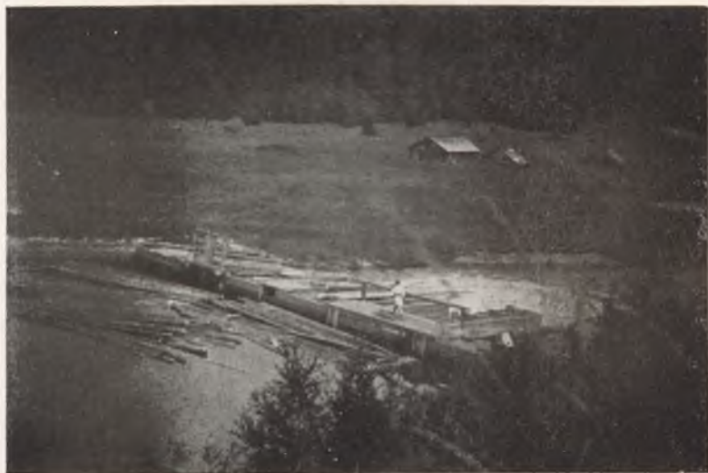
Fig. 15. — Pârăul Neagra-Broşteni. Haitul dela Poiana Vinului.]
