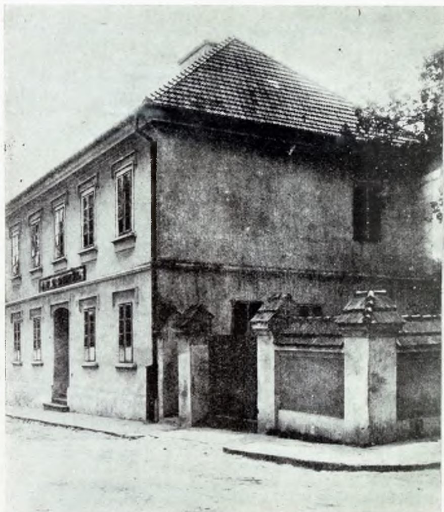
Școala primară (National-Hauptschule) cercetată (1858—1860) de elevul Mihai Eminovici
